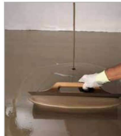
Fig. 5.2 - Lisciatura di massetto cementizio con ULTRAPLAN
