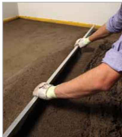
Fig. 3.4 - Staggiatura del massetto
