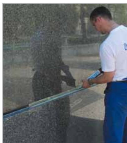
Fig. 4.12 - Sigillatura di giunto di facciata con MAPELIL LM
