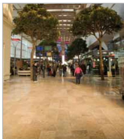
Fig. 4.6 - Esempio di posa di pietra naturale con GRANIRAPID - Stazione ferroviaria di Marsiglia - Francia
