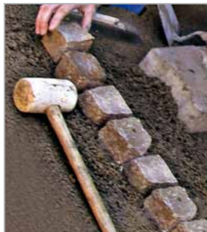
Fig. 5.3 - Applicazione di cubetti in porfido mediante MAPEDRAIN MORTAR
