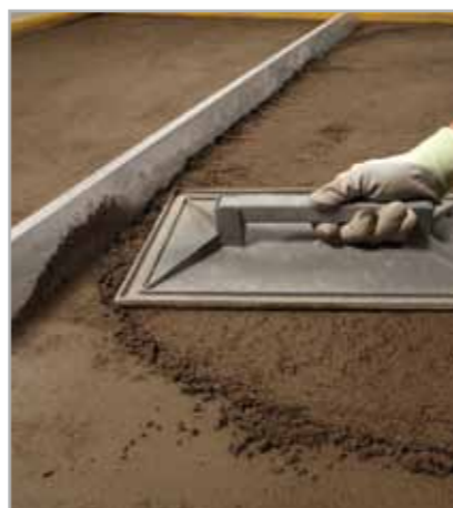
Fig. 3.5 - Frattazzatura della superficie del massetto
