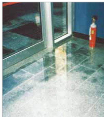
Fig. 2.6 - Esempio di macchiatura su pavimentazione in granito
