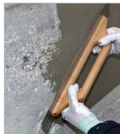
Fig. 3.9 - Regolarizzazione di parete con PLANITOP FAST 330
