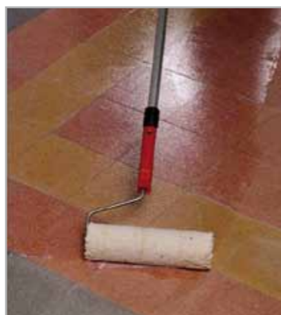
Fig. 3.6 - Applicazione di primer promotore d'adesione
