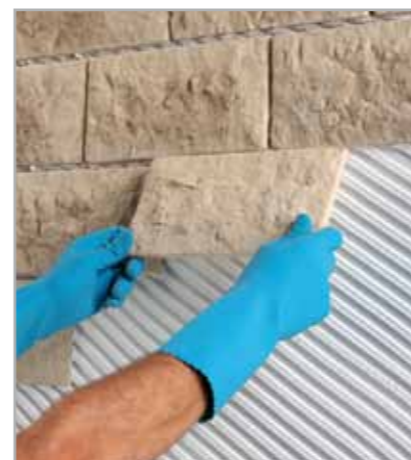
Fig. 5.1 - Posa di elementi decorativi ricomposti con FIX & GROUT BRICK
