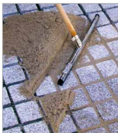
Fig. 5.4 - Applicazione di MAPEDRAIN 1K GROUT
