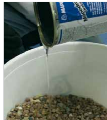
Fig. 5.6 - Confezionamento di malta per fughe per lastricati con MAPEDRAIN BINDER
