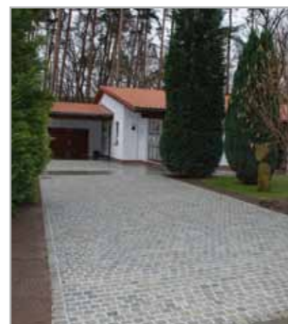
Fig. 5.8 - Esempio di posa e stuccatura di lastricato in porfido realizzata con MAPEDRAIN MORTAR e MAPEDRAIN 1K GROUT
