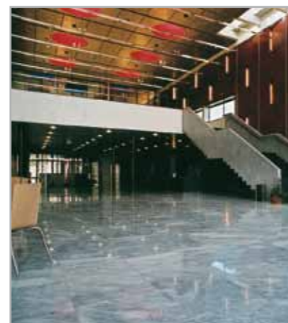
Fig. 4.8 - Esempio di posa di pavimento in marmo con KERAQUICK - Hall del Casinò di Feuchtswangen - Germania
