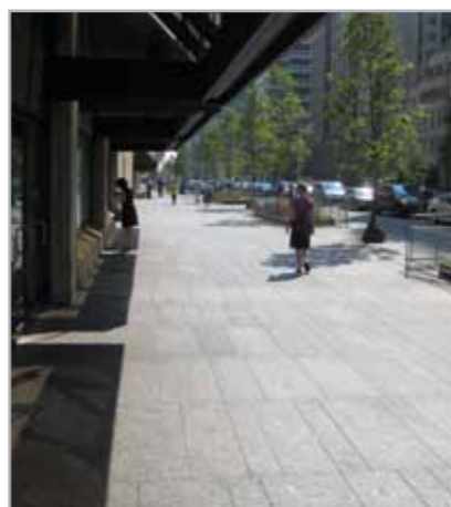
Fig. 4.5 - Esempio di posa di granito con GRANIRAPID - Bloor Street, Toronto - Canada
