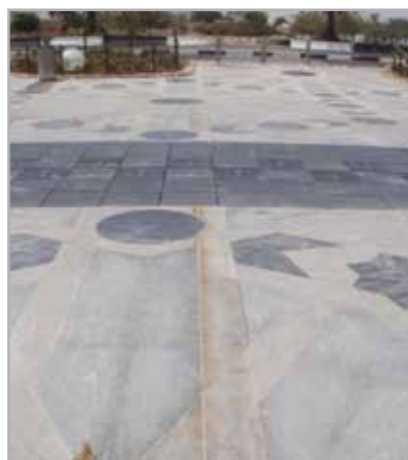
Fig. 4.11 - Esempi di macchiatura della pietra naturale legati all'utilizzo di un sigillante siliconico a reticolazione acetica
