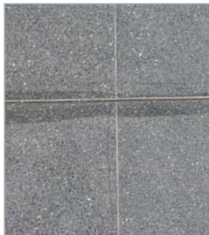
Fig. 4.10 - Esempi di macchiatura della pietra naturale legati all'utilizzo di un sigillante siliconico a reticolazione acetica
