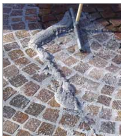
Fig. 5.5 - Applicazione di MAPEDRAIN 3K GROUT
