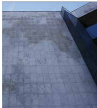
Fig. 2.5 - Esempio di macchiatura da pirite su marmo bianco di Carrara
