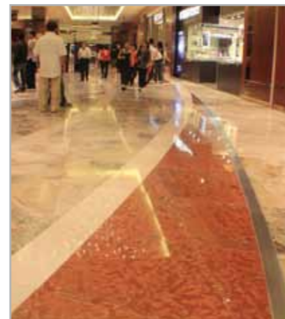
Fig. 4.7 - Esempio di posa di marmo con ELASTORAPID - Marina Bay Sands Resort - Singapore
