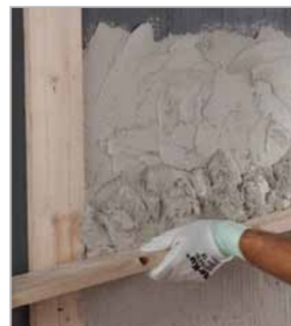
Fig. 3.8 - Regolarizzazione di parete in calcestruzzo con NIVOPLAN+PLANICRETE
