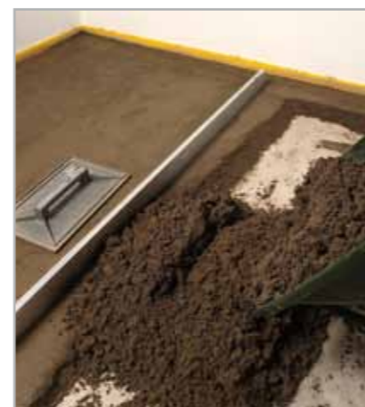
Fig. 3.3 - Realizzazione di massetto in MAPECEM PRONTO
